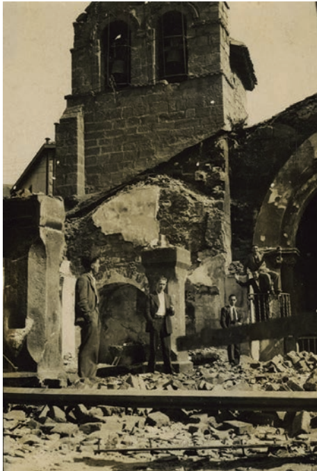
Estado en que quedó la iglesia de Santo Tomás tras el incendio que sufrió en la madrugada del 6 de octubre de 1934.
