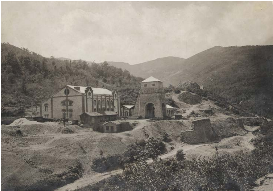
Vista del Pozo Calero.
